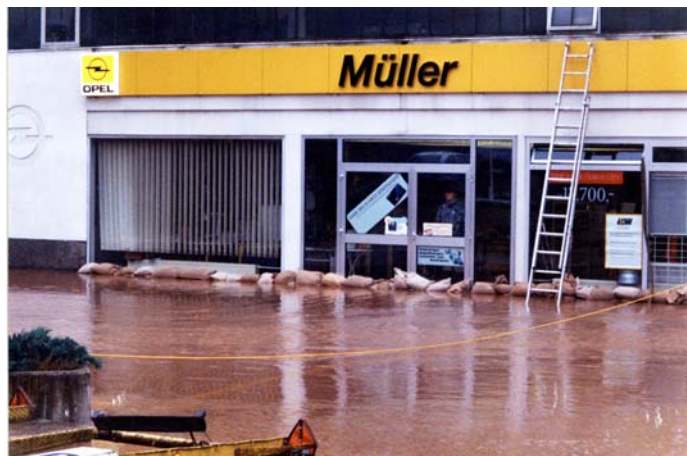
Schadenspotenzial durch Bebauung in Überschwemmungsgebieten
