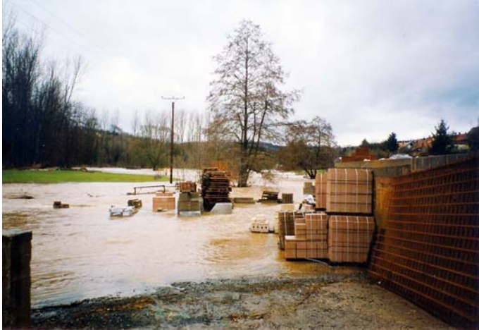
Unsachgemäße Lagerung in Überflutungsbereichen
