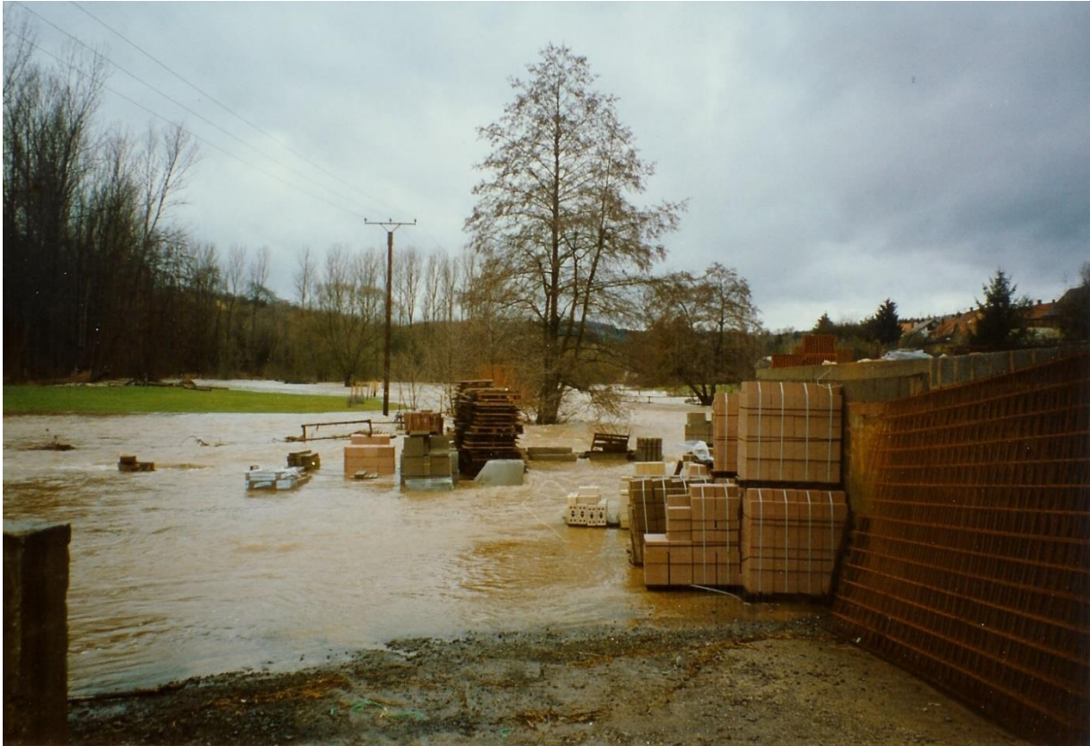
Unsachgemäße Lagerung in Überflutungsbereichen
